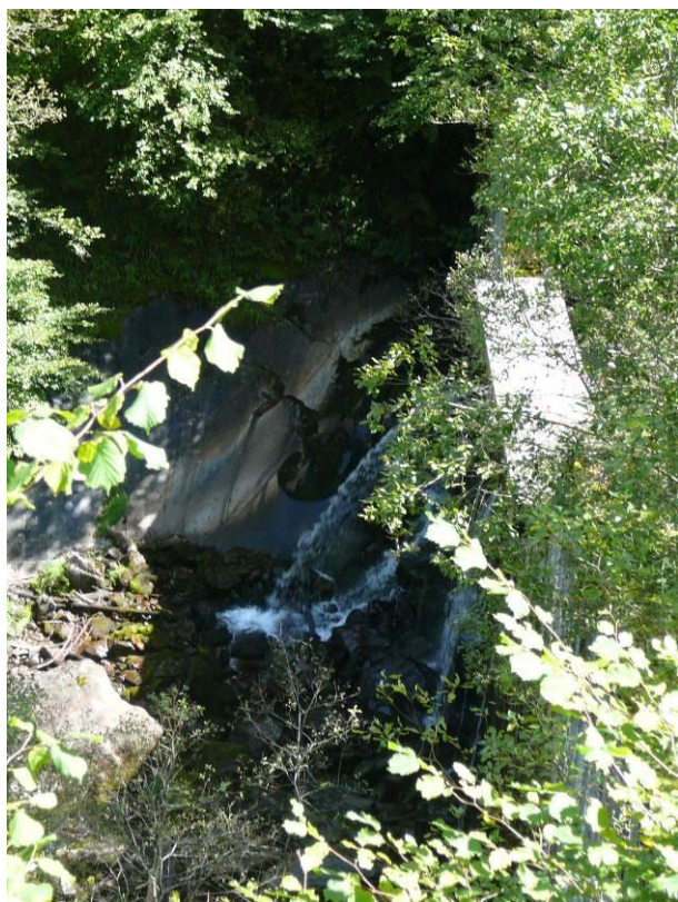
Barrage situé en aval du carreau 1230
