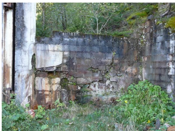
Mur abritant la cuve de fioul du carreau 1230
